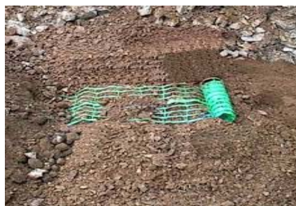
Grillage avertisseur vert – Equipement souterrain
